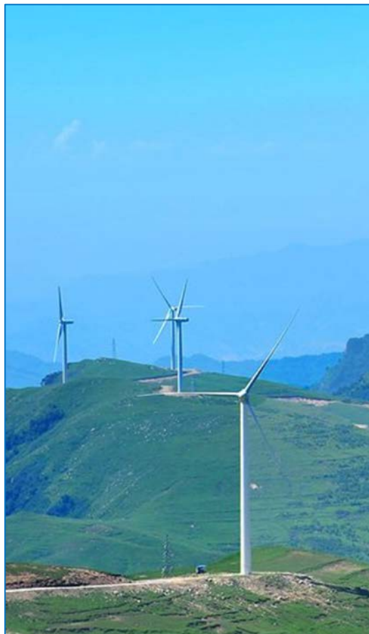
华南集团某风电场项目
