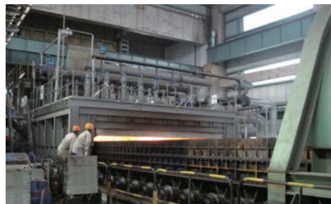
宁波某钢铁2x7800kW主抽风机变频改造项目
