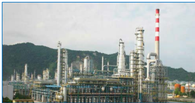
福建某炼油化工厂消弧改造项目
