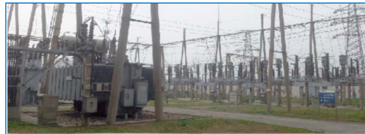
广东电网某供电局项目
